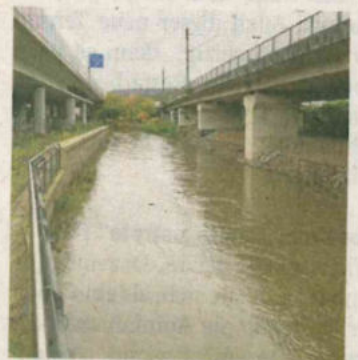
Von der Brücke über dem Deilbach lässt sich der hohe Wasserstand gut erkennen.
